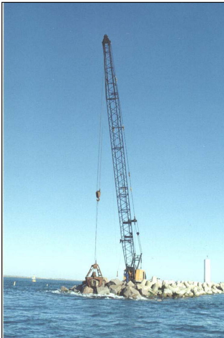
Figura 9. Atividade de colocação de pedras na extremidade do Molhe Leste.
